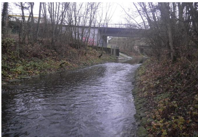
Foto gegen Fließrichtung
