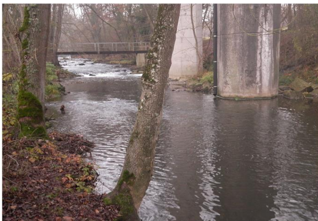
Foto gegen Fließrichtung
