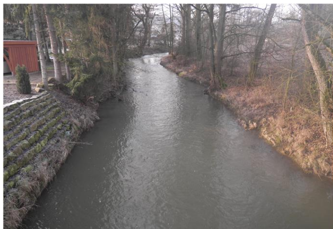
Foto gegen Fließrichtung
