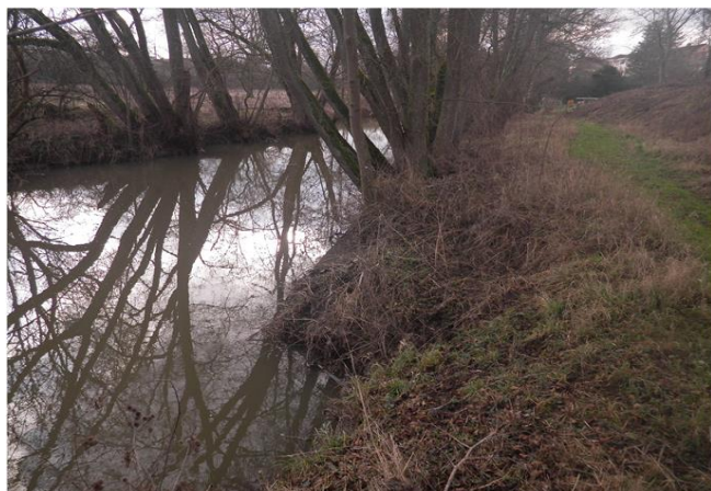
Foto gegen Fließrichtung
