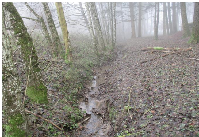
Foto gegen Fließrichtung
