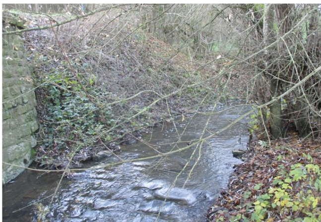
Foto gegen Fließrichtung
