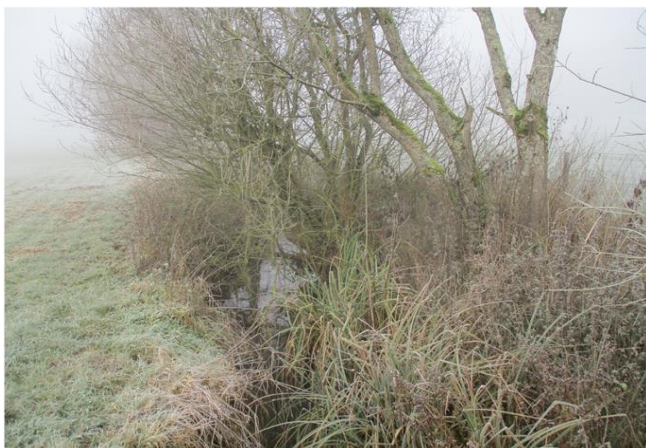
Foto gegen Fließrichtung
