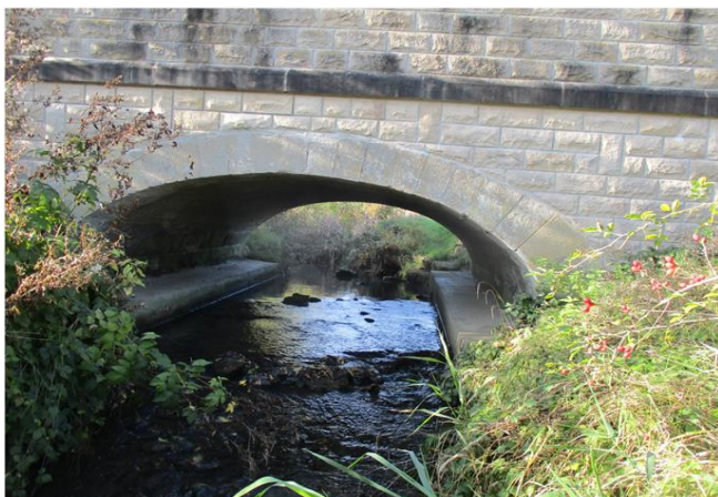
Foto gegen Fließrichtung
