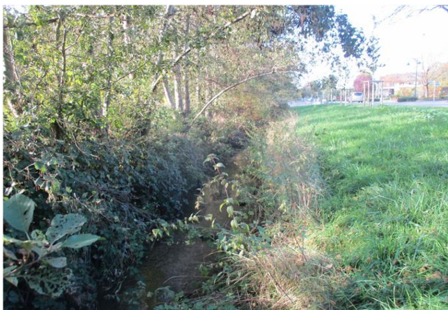
Foto gegen Fließrichtung
