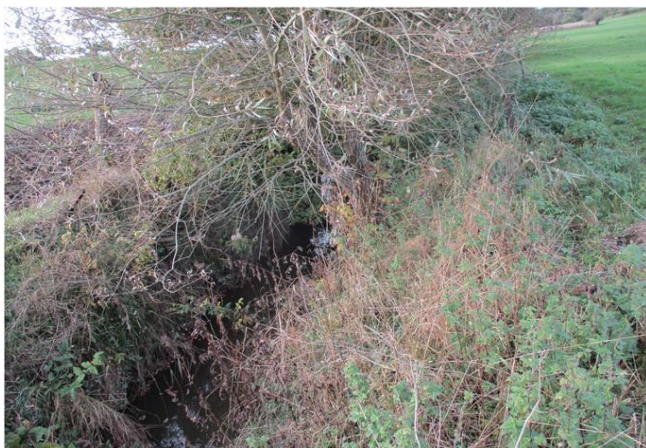
Foto gegen Fließrichtung
