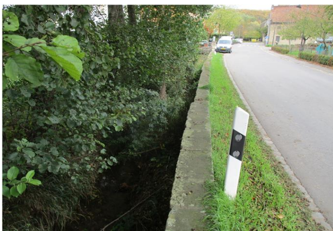
Foto gegen Fließrichtung
