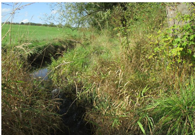
Foto gegen Fließrichtung
