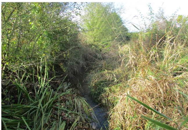
Foto gegen Fließrichtung
