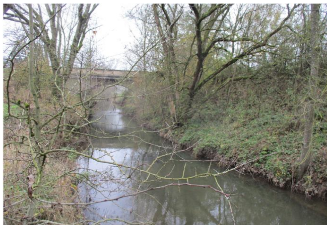
Foto gegen Fließrichtung
