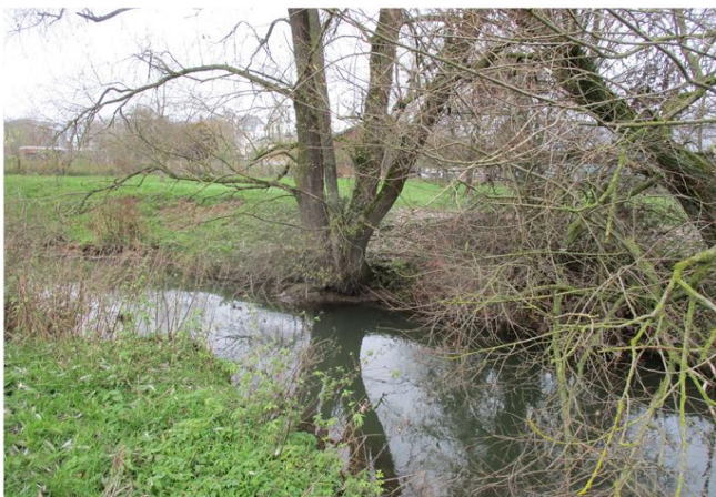
Foto gegen Fließrichtung
