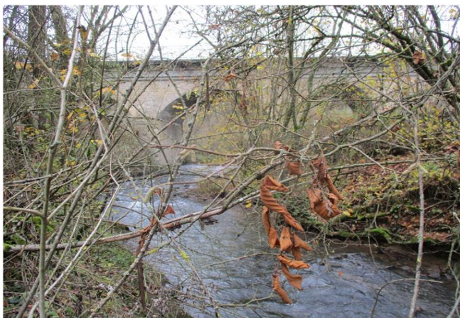
Foto gegen Fließrichtung
