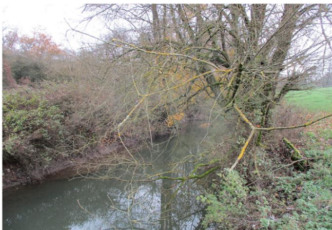
Foto gegen Fließrichtung
