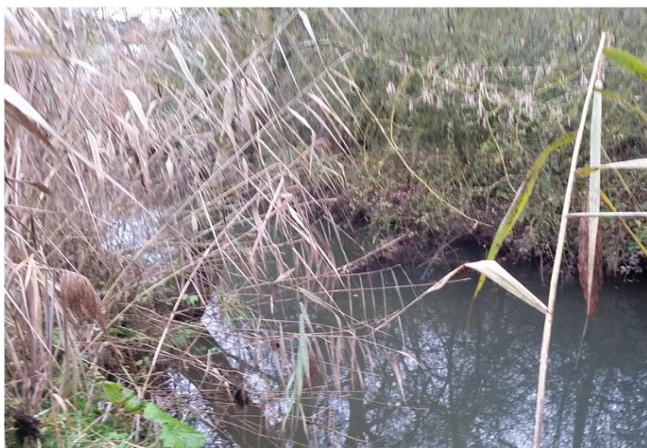
Foto gegen Fließrichtung
