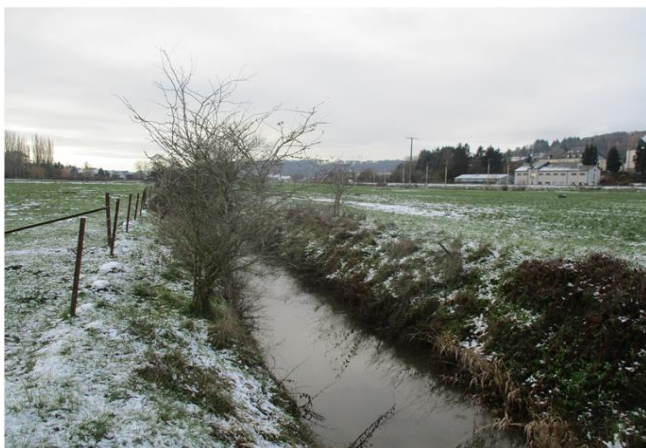
Foto gegen Fließrichtung
