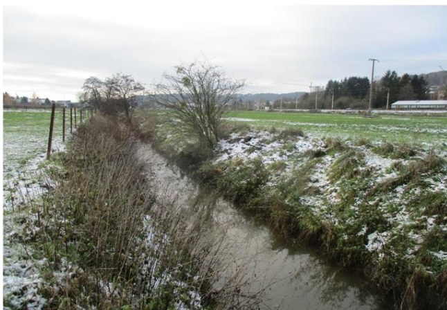
Foto gegen Fließrichtung
