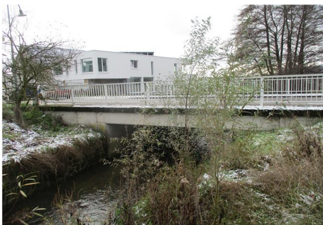
Foto gegen Fließrichtung
