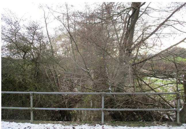
Foto gegen Fließrichtung
