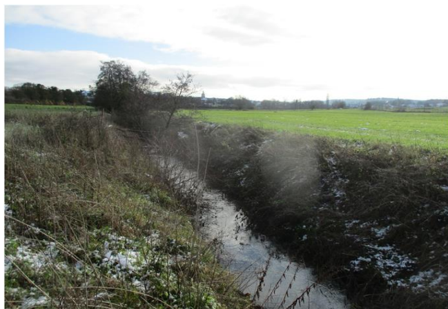
Foto gegen Fließrichtung
