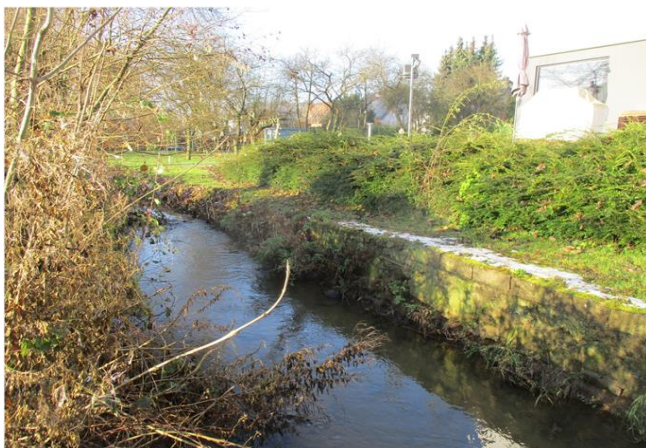
Foto gegen Fließrichtung
