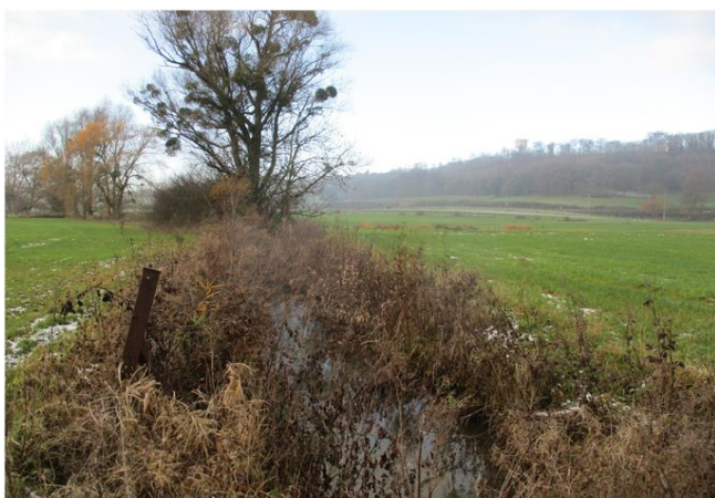
Foto gegen Fließrichtung
