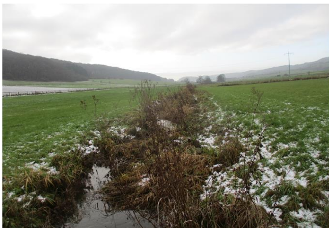
Foto gegen Fließrichtung
