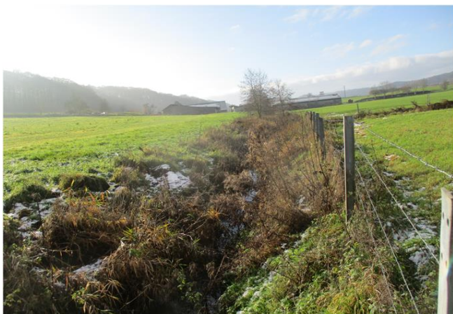
Foto gegen Fließrichtung
