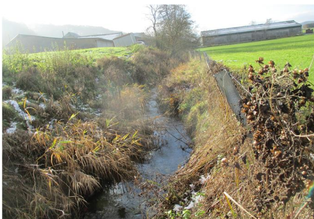
Foto gegen Fließrichtung
