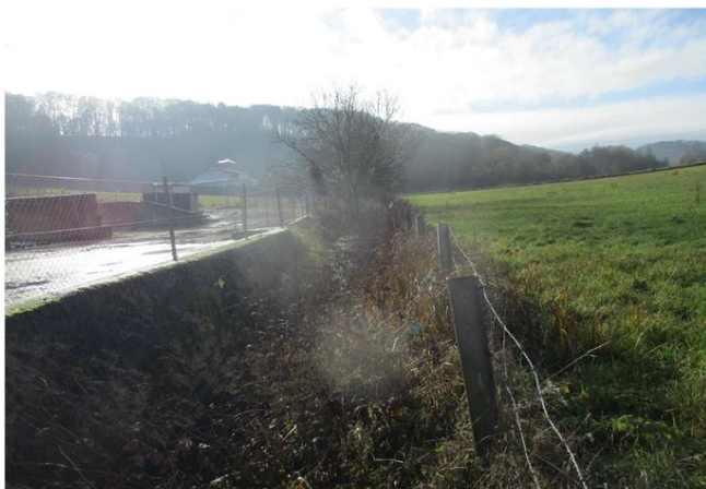
Foto gegen Fließrichtung
