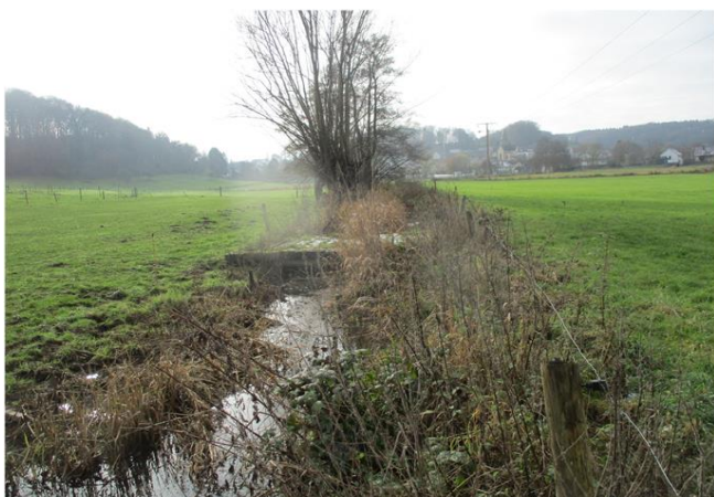
Foto gegen Fließrichtung
