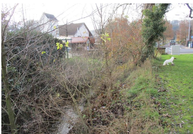
Foto gegen Fließrichtung
