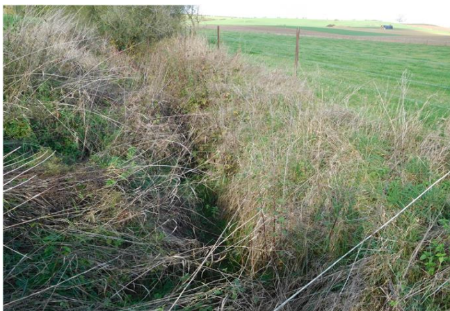
Foto gegen Fließrichtung
