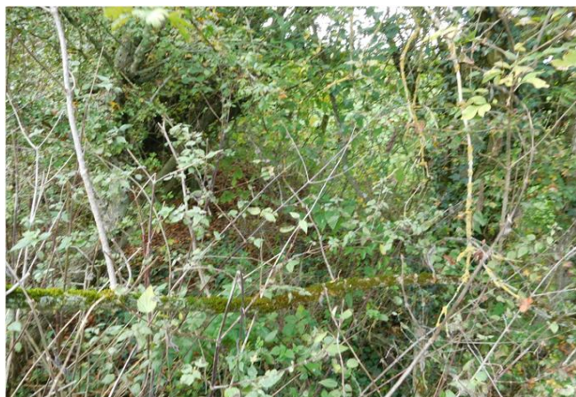
Foto gegen Fließrichtung
