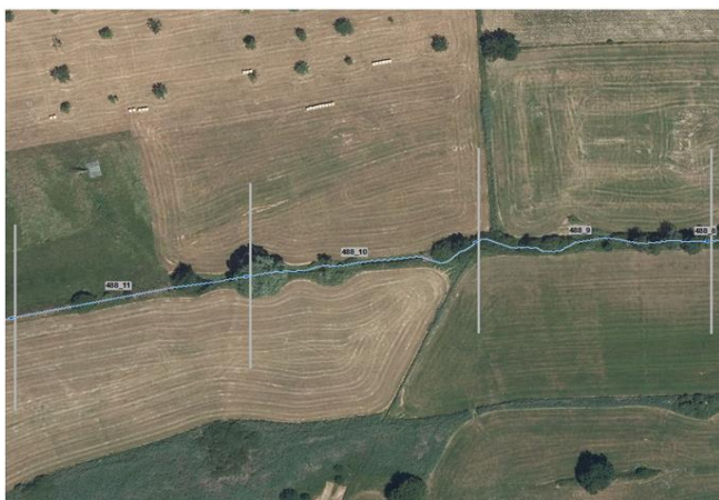
Foto gegen Fließrichtung
