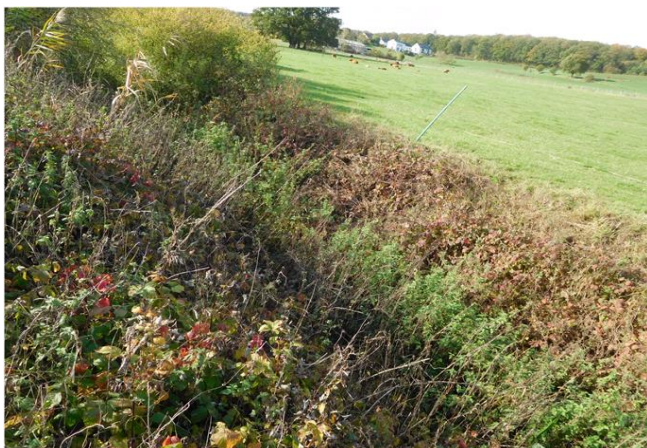
Foto gegen Fließrichtung
