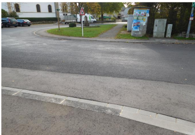
Foto gegen Fließrichtung
