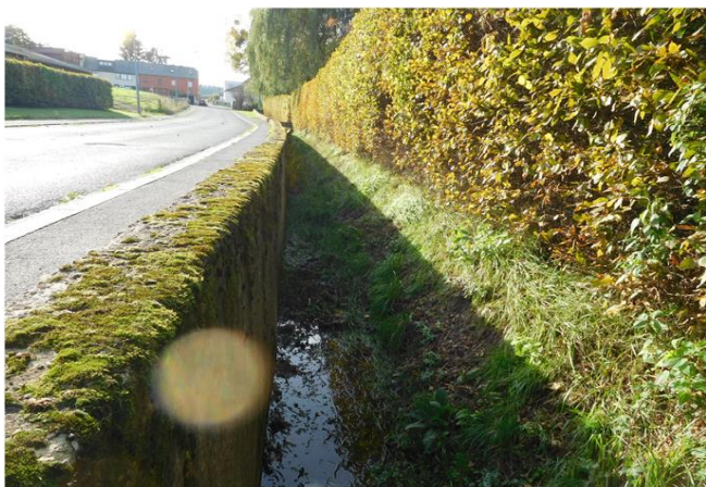
Foto gegen Fließrichtung
