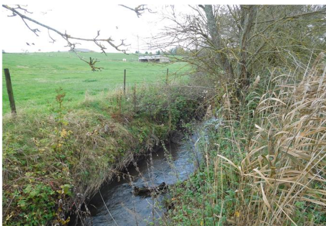
Foto gegen Fließrichtung
