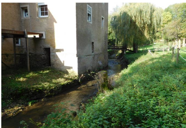
Foto gegen Fließrichtung
