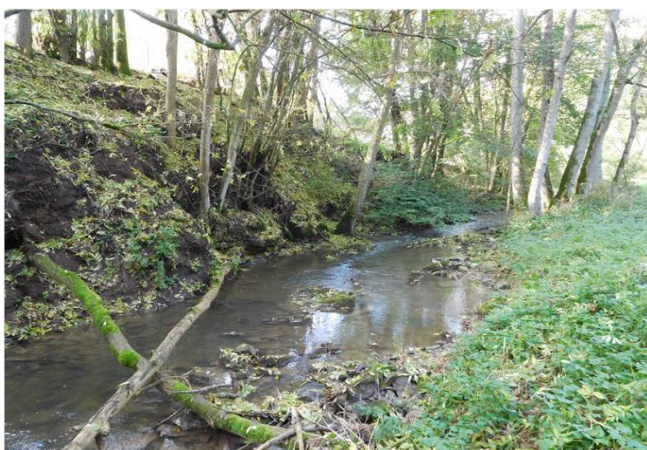
Foto gegen Fließrichtung
