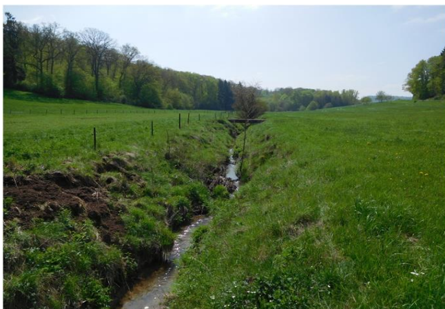
Foto gegen Fließrichtung
