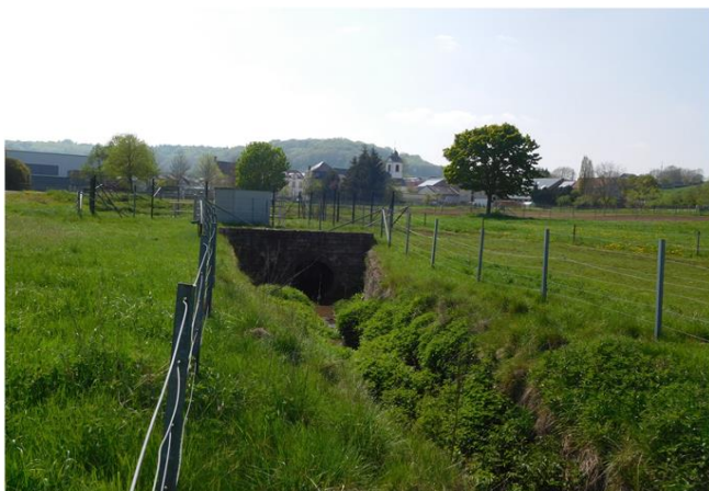
Foto gegen Fließrichtung
