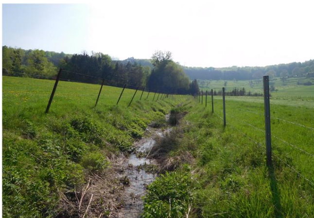
Foto gegen Fließrichtung
