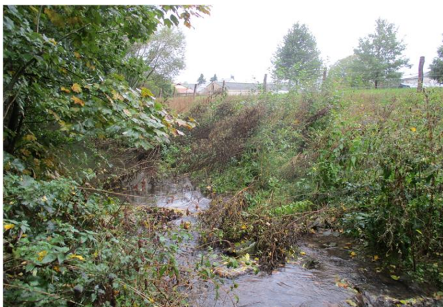
Foto gegen Fließrichtung
