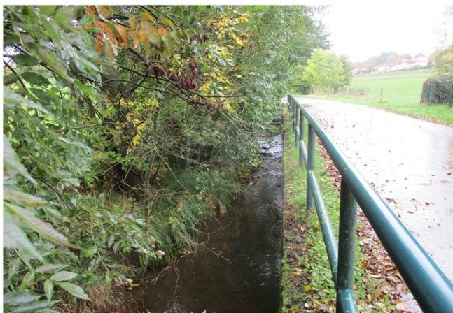
Foto gegen Fließrichtung
