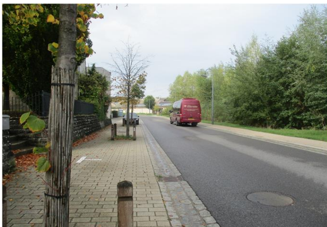
Foto gegen Fließrichtung
