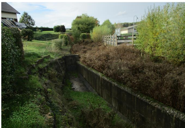
Foto gegen Fließrichtung
