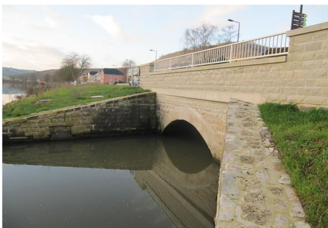
Foto gegen Fließrichtung
