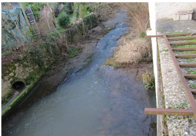
Foto gegen Fließrichtung
