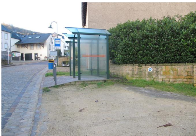
Foto gegen Fließrichtung
